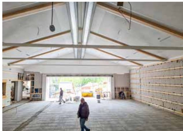
Mit Oktober sind die Baurbeiten beim Goldrainer Vereinssaal abgeschlossen.
