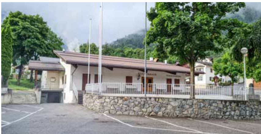
Für das Vereinshaus Morter wurde eine Machbarkeitsstudie zur Sanierung erstellt.
