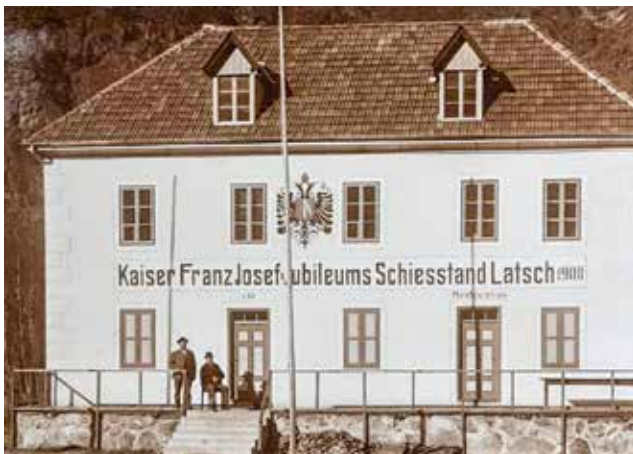
Ab September wird der historische Schießstand in Latsch saniert.
