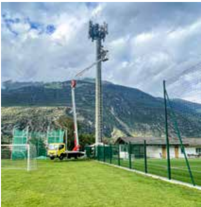
Die neuen Lampen wurden innerhalb von zwei Tagen montiert.
