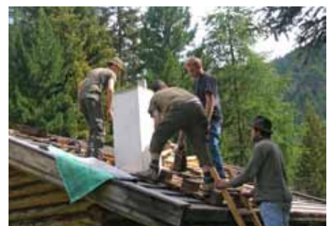
Arbeiten am Kamin der Fischerhütte
