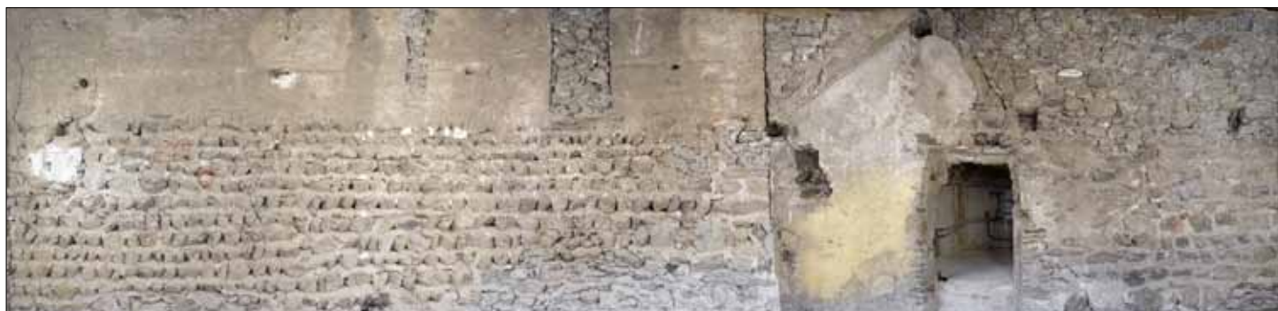
Ansicht der Mauer der Dachgeschosswohnung: erkennbar die Zinnen auf der einstigen Außenmauer. Typisches Erkennungsmerkmal einer romanischen Mauer sind die regelmäßigen, horizontal ausgerichteten Steinlagen.
